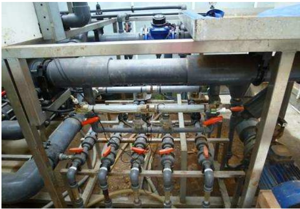
圖 2-13.位於機房的養液控制系統
