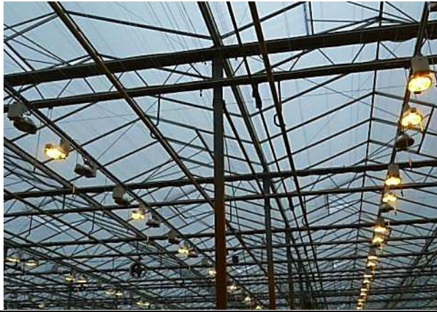
圖 2-5. 溫室上方高壓鈉燈進行補光，左排亮燈數 1/3，為洋桔梗苗定植初期電照。右排亮燈數 2/3，為洋桔梗生育中期。
