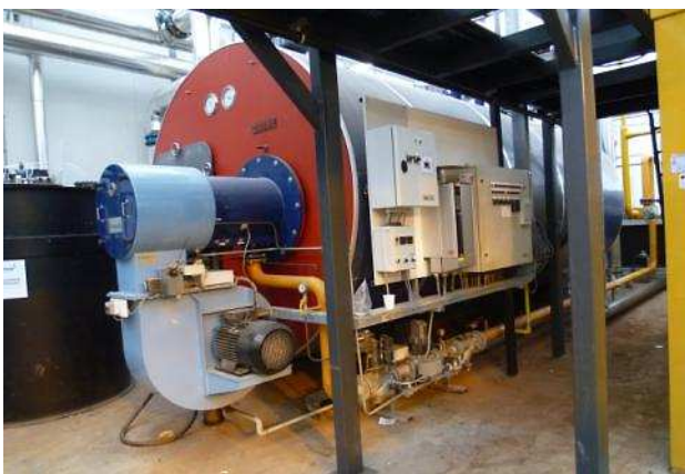
圖 2-26. 高溫蒸氣製造機，分為 2 階段升溫，第一階段產生 120°C 蒸氣，第二階段再將 120°C 蒸氣加溫至 150°C。
