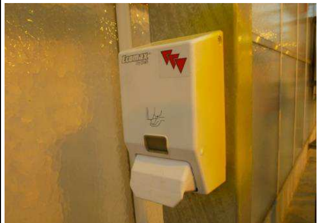
圖 5-20.溫室內部設置洗手液供員工使用以保持田間衛生安全。
