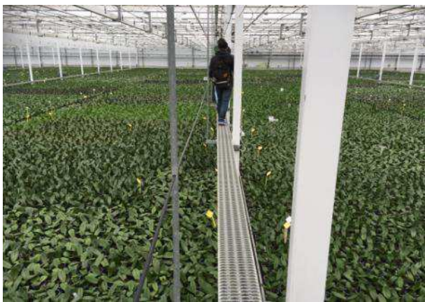
圖 5-9.溫室梁柱間的天空走道，僅容一人通過，走道寬度約 20~25cm。
