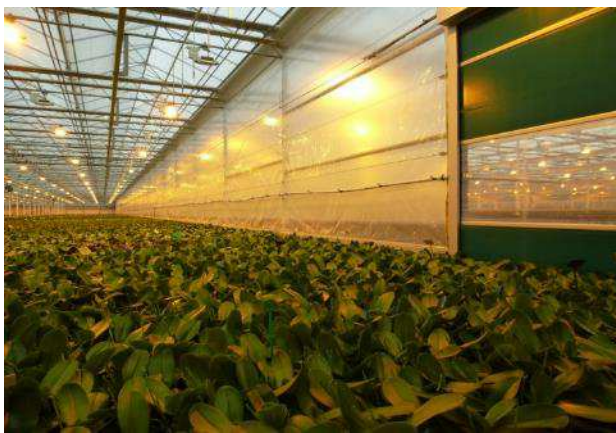
圖 5-19.不同栽培區以保溫塑膠布隔絕，門簾為上下捲動，自動開啟關閉。
