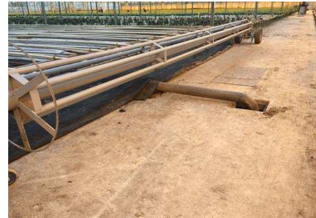
圖 2-24. 開始進行高溫蒸氣燻蒸，由地底高壓蒸氣管線接上蒸氣釋放棒。
