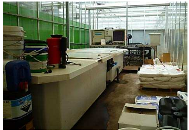
圖 2-14.灌溉系統操作室，包括養液之母液配製槽以及肥料堆放等。
