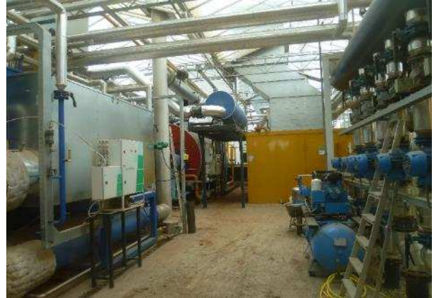
圖 2-28.機房，有氣電共生系統、高溫蒸氣系統、及其他控制系統等，供應溫室環控生產所需。
