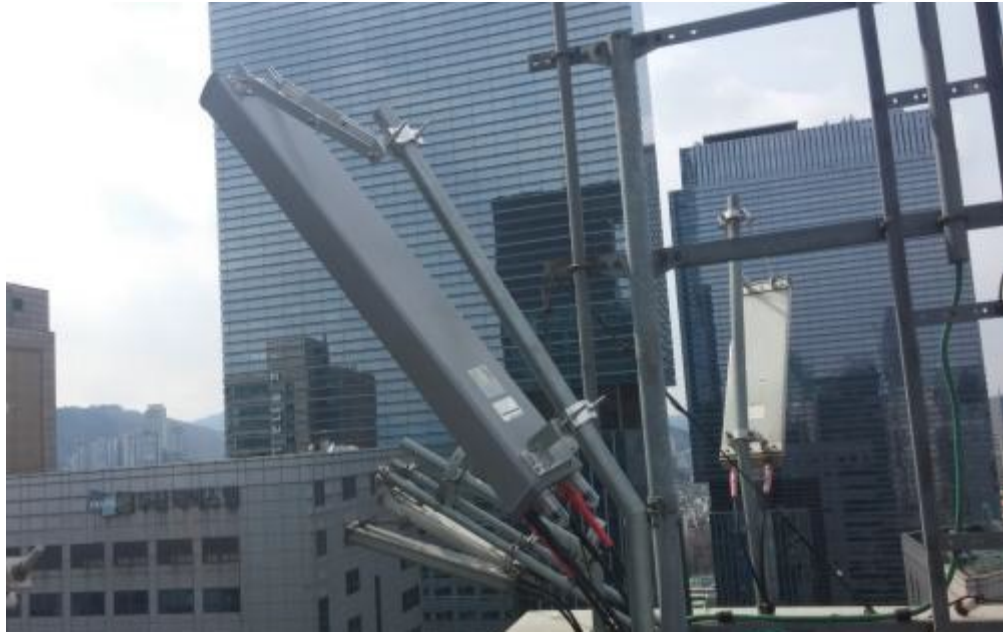
圖 9、LG U+ 基站超大下傾角佈建
