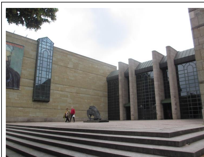
Neue Pinakothek 的大廳入口處有大片玻璃引入自然光
