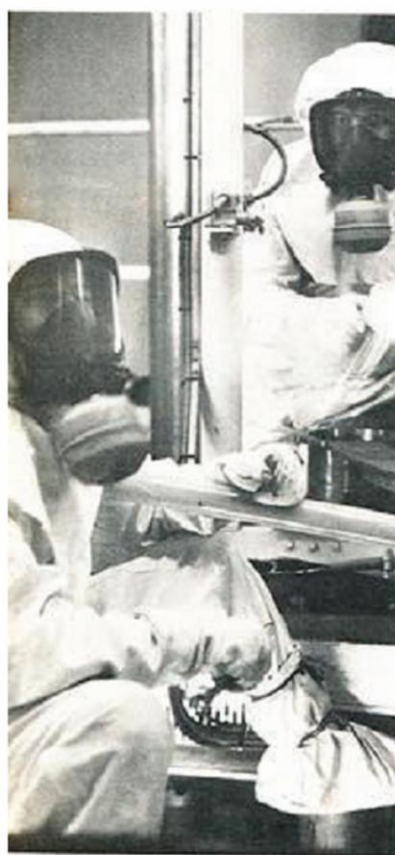
Réparation d'un appareil de manipulation de l'uranium à la centrale de Saint-Laurent-des-Eaux.
