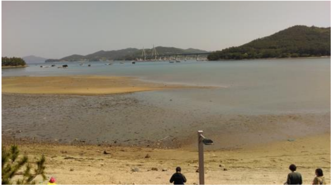
(26)2014 年建成的跨海大橋
