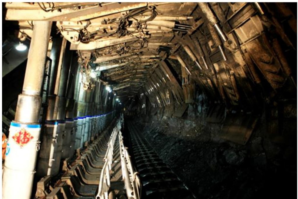
採礦面錨桿支架
