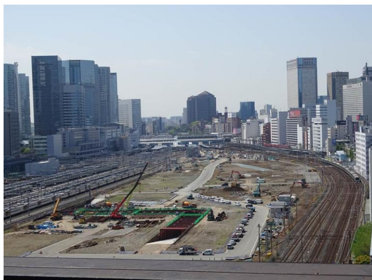
圖 22 東日本車輛基地現況-2
