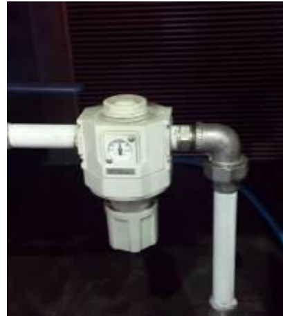
圖(3-21)減壓閥端口及連接口
