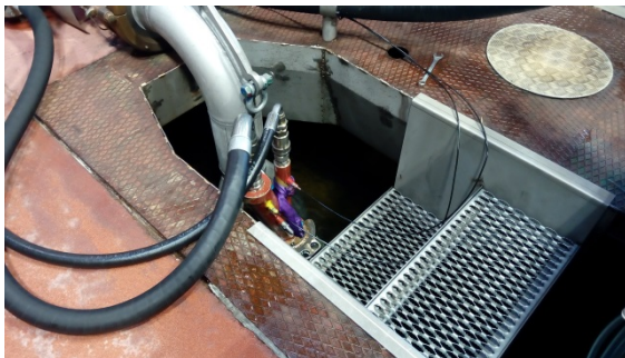
貨油泵組裝完成(安裝於測試水池)
