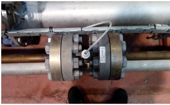
液壓油流量計SENSOR
