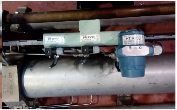
液壓油及回油壓力與輸出水頭SENSOR
