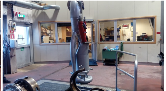
貨油泵組裝(吊入測試水池中)
