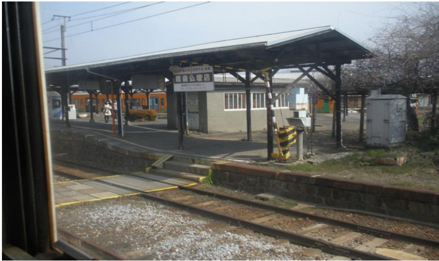
圖42 近江鐵道車站內通道設置平交道
