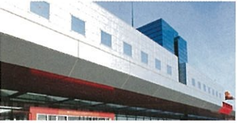
9 神戸インキュベーションオフィス (KIO)
