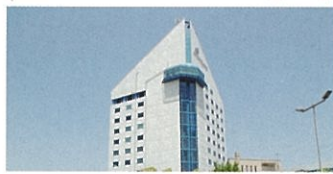
11 ポートアイランドビル (PI 1期)
