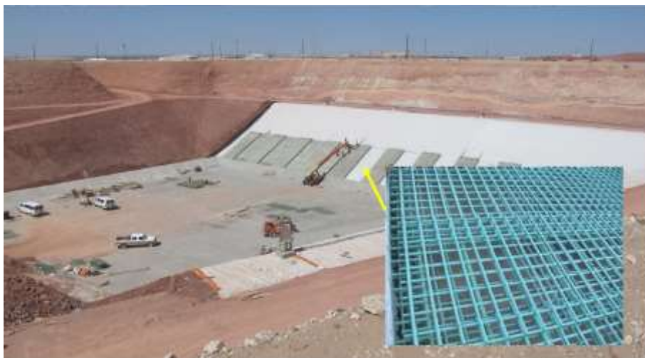
圖 35.WCS 掩埋場事前準備工作，圖右綠色為鋪上的鋼筋材質
