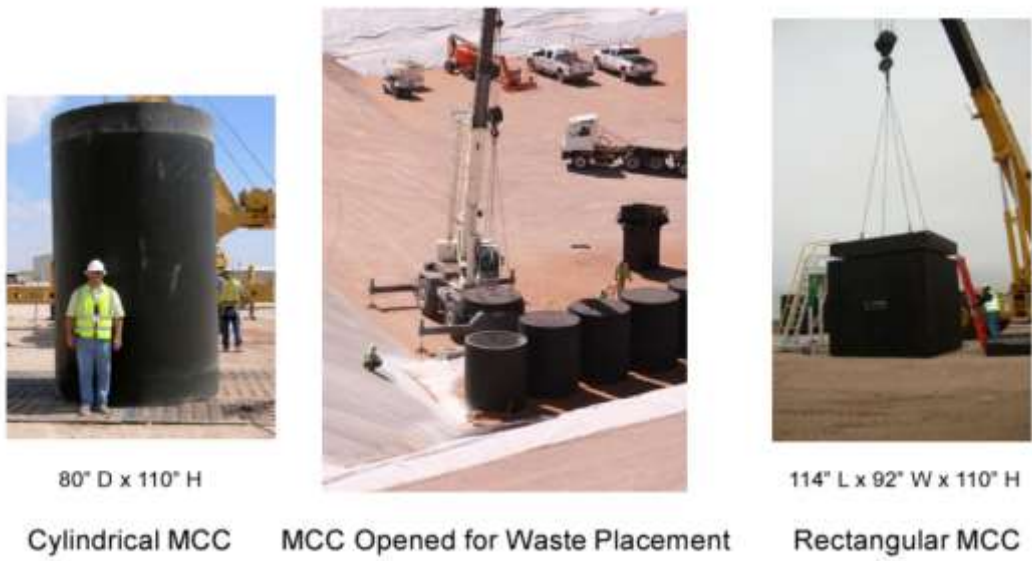
圖 36.MCC 模塊化混凝土罐內部先裝入 55 加侖桶後再以水泥封裝
