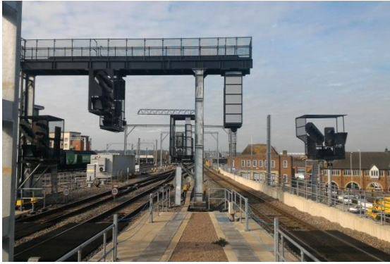
圖62. Reading 電氣化施工中
