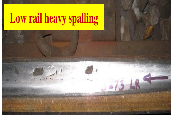
圖23.彎道鋼軌磨損問題
