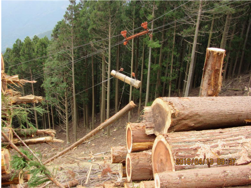
照片 11：參訪集運現場所使用架線集材為泰勒循環式架線，透過集材機操控鋼索，搬器可在主索上搬運原木。
