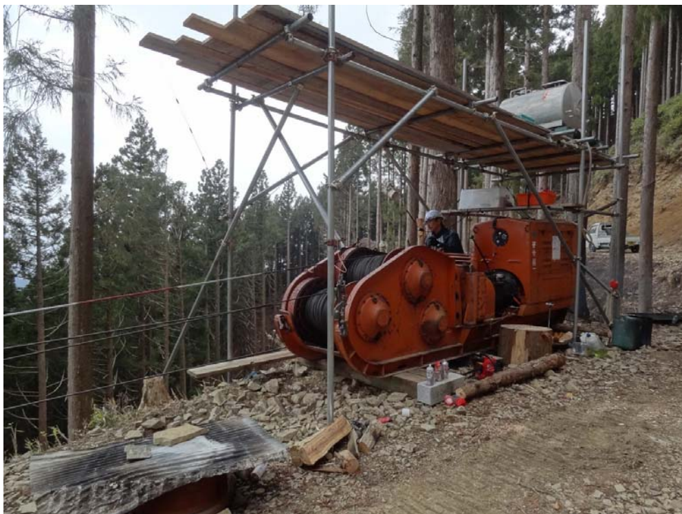
照片 12：集材現場採用之油壓高效率三胴集材機，該機體積小，易於搬動移位。
