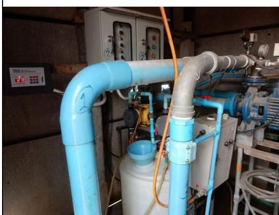
圖45.可與軌道噴水設備共用的自動肥水供應系統
