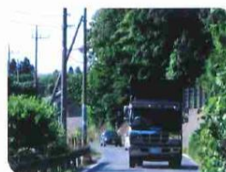
歩道未設置で狭い道路幅員
