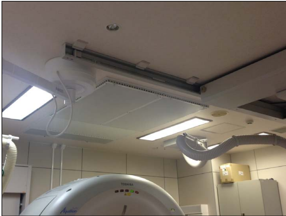
Fig 6. 正壓通氣過濾系統，減少落塵量，有效降低術中感染率
