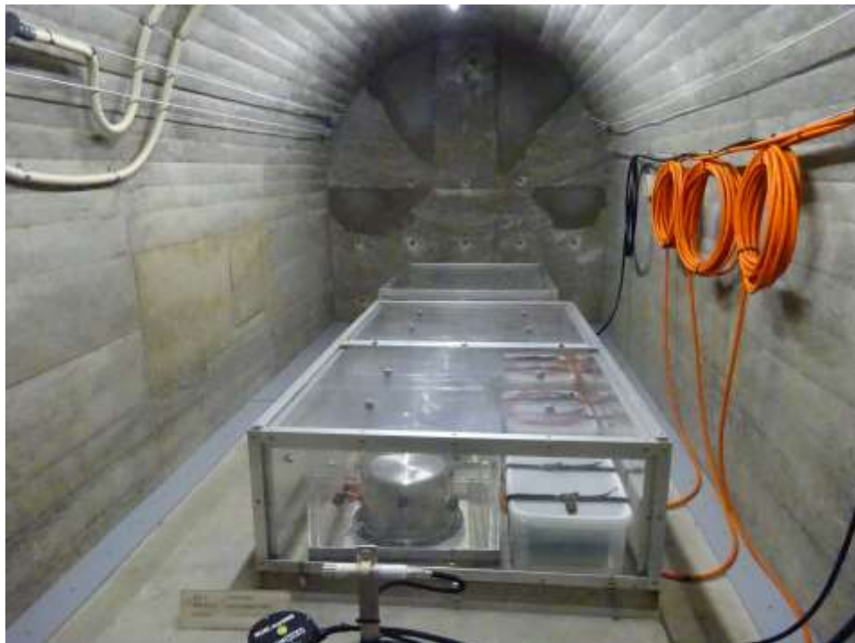
筑波地震站山洞內儀器擺設情形。
