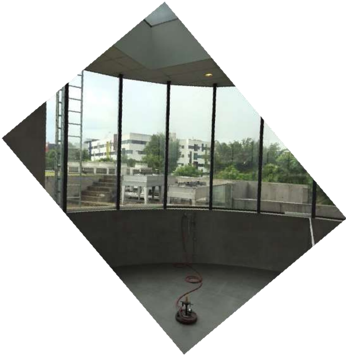
探空站一景，頂部天花板可以開合，底部為探空氣球充氣底座。
