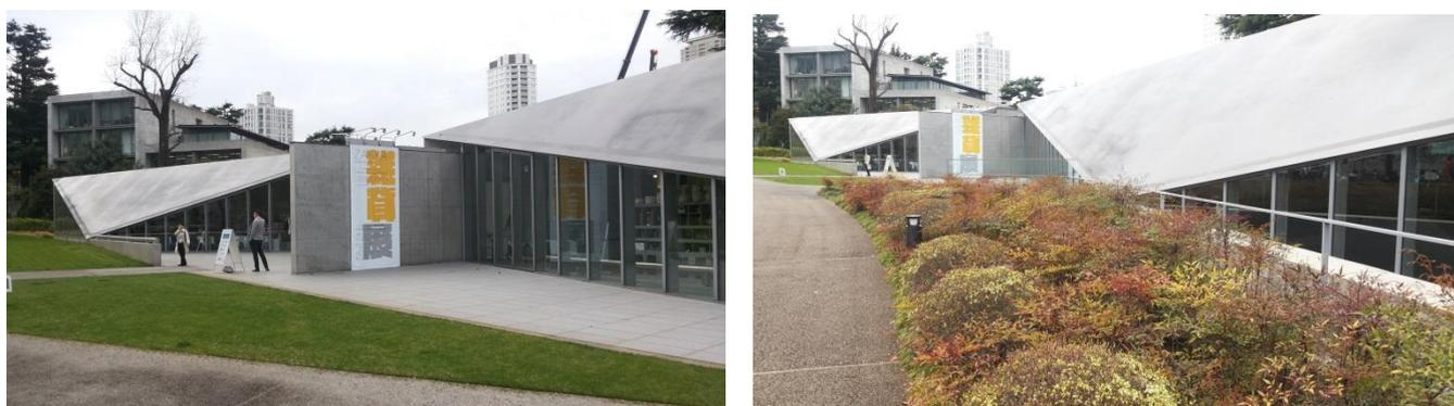
「一塊布，A-POC (A Piece Of Cloth)」的日本和服美學而建造，並將此概念融合在建築的幾何設計中，設計出二塊倒三角型的屋頂，以 25 片長達 50 公尺的一整塊鐵板折製銲接而成：一為美術館，其次為餐廳，將文化引進建築物中，讓設計跟生活的豐富性在此交流，也落實「透過設計來看世界的場所」的初衷。
