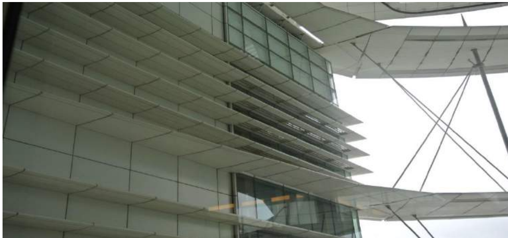
圖 124 空橋與鰭片式的建築外殼設計
