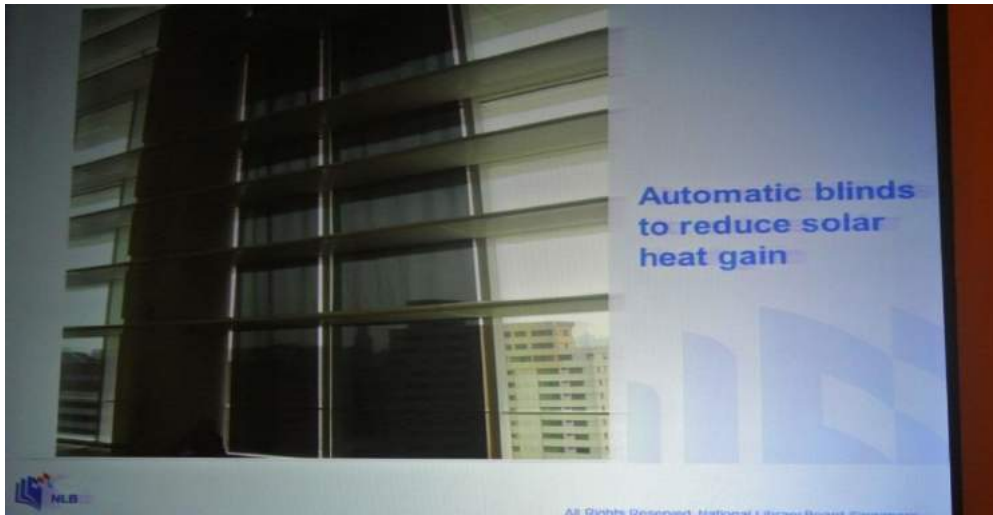
圖 125 透過光感應器，使用百葉窗控制光量並隔絕熱輻射
