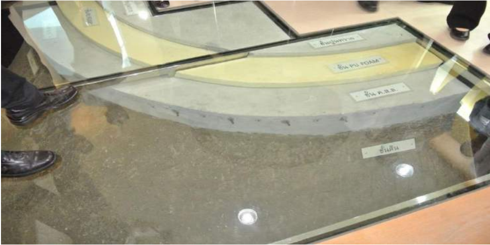
圖 115 地板選用隔熱材料
