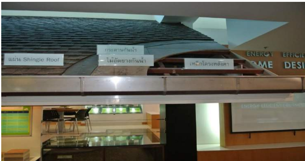
圖 113 適當選用屋頂材料，可阻絕輻射熱，節省空調使用
