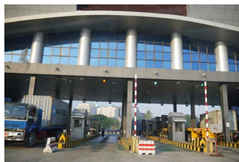
照片 入口閘門車道
