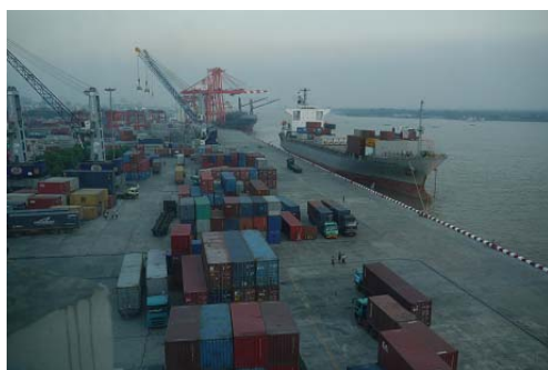
照片 碼頭裝卸設施
