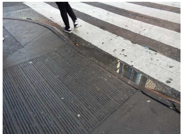
路緣斜坡與車道銜接處積水
