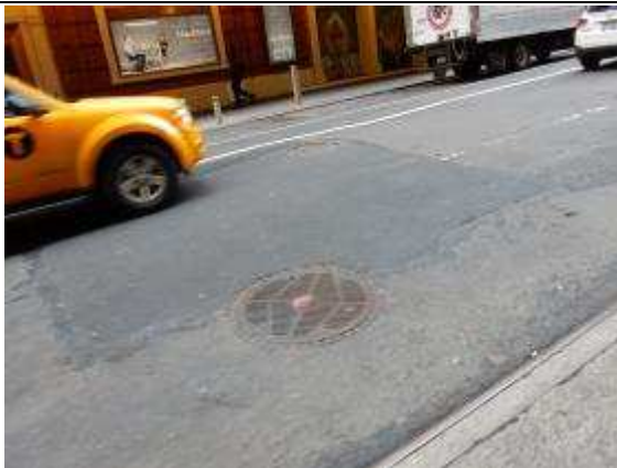
人/手孔的銜接與方正切割情形，有些微的高低差，且標線已淡掉，並未補繪。
