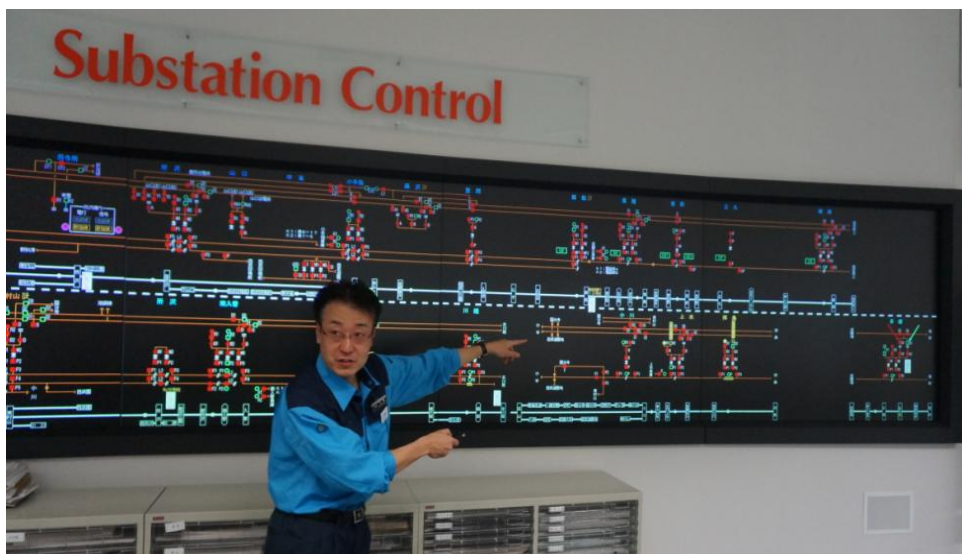
圖 19 電氣司令為本考察團簡介電力調配系統
