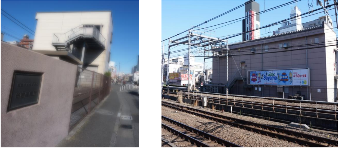
圖 39 新宿變電站與中性區間設備
