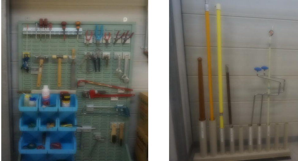
圖 41 變電站內排列整齊之工具
