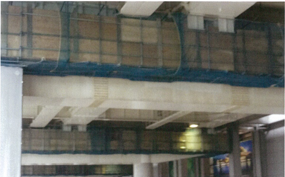
進行中工程妥善防護
