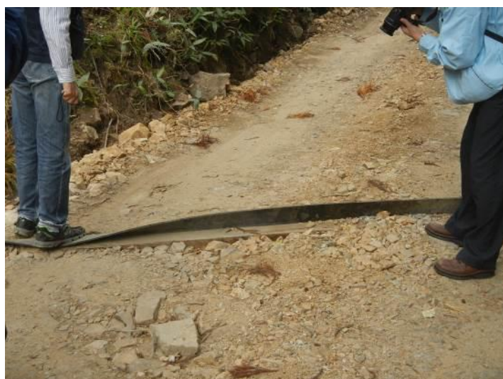
圖 26 以輸送帶廢材輔助作業道排水
