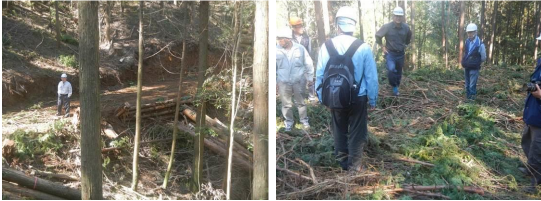
圖 20 作業道利用現地原木構築及鋪設枝葉防滑
