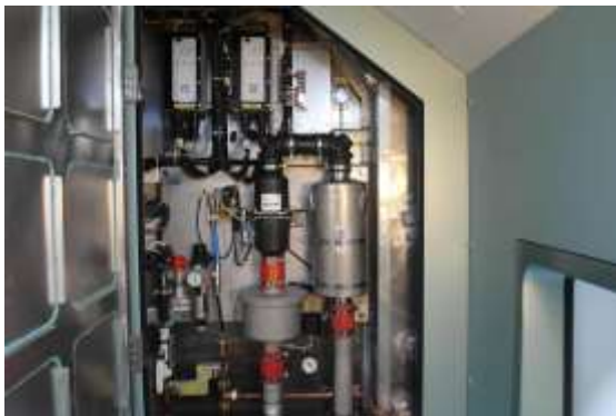
圖 3-29 廁所設備裝配
