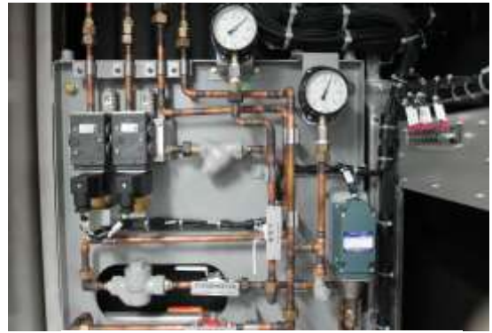
圖 3-22 空氣壓力調整確認
