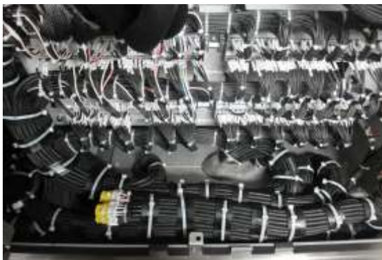
圖 3-44 駕駛室後方線路作業
