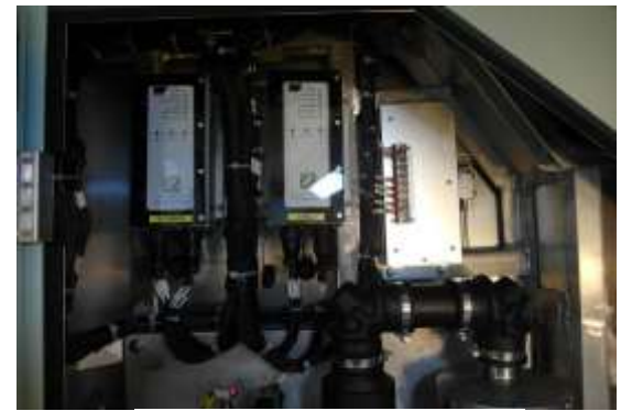
圖 3-30 廁所設備裝配
