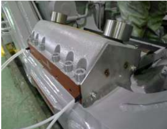
圖 3-15 注油管外部用塑鋼土將縫隙填滿注油管用膠帶包覆以免擦傷
