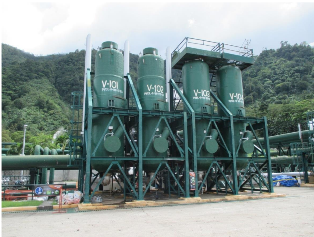
圖 8、督馬庫特地熱電廠的蒸氣與熱水分離器。
