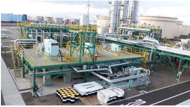
圖 16 三階段 CO 2 壓縮機
