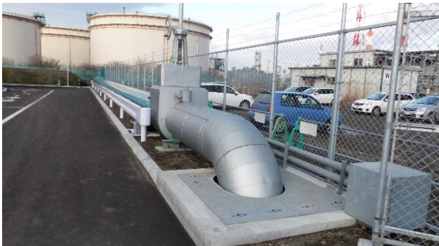
圖 12 PSA 分離氣體(含 CO 2 )輸送管線
