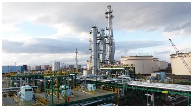
圖 15 CO 2 捕獲高塔設備
