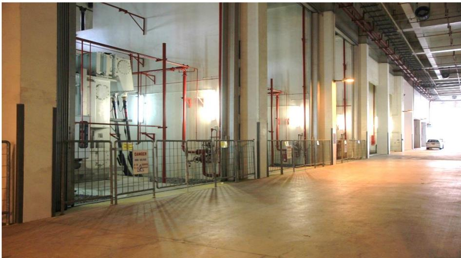
圖 23 屋內式變電所變壓器設置處所不以變壓器室實體隔離，並保留足夠運行空間
