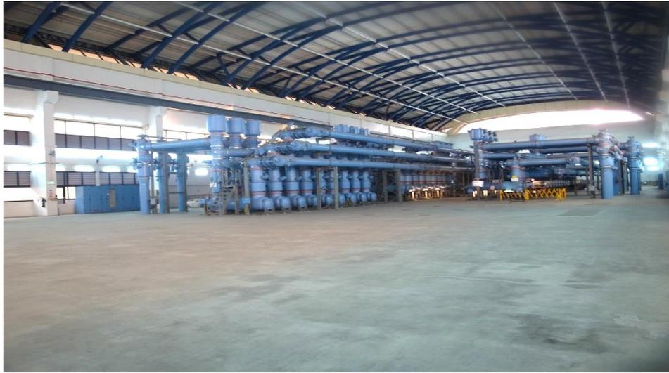
圖 24 室內變電所 230kV GIS 室 設備，室內尚餘約 1/2 面積空間
