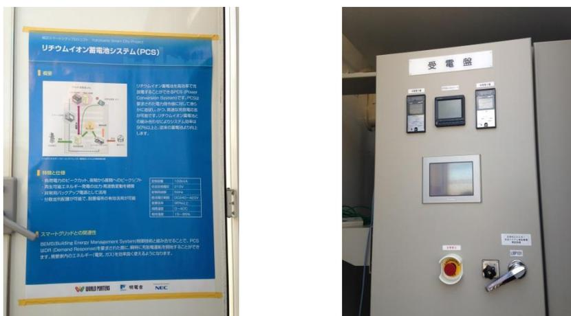
照片 10、YSCP 中 NEC 的 PCS 設備(置於受電盤配電箱中)
