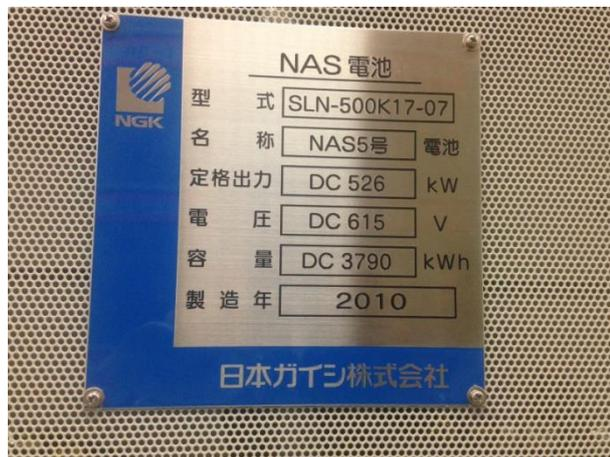
照片 5、沖繩宮古島的 NaS 電池儲能系統單櫃規格
