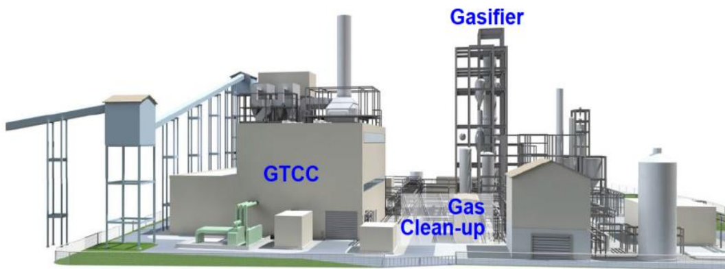
圖 2 勿來發電廠 IGCC 機組全景圖
