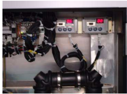
圖 2-17：小便斗故障 RS 控制盒顯示 圖 2-18：小便斗故障 RS 控制盒顯示
