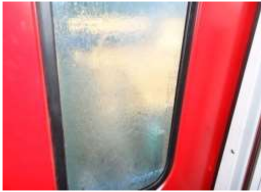
圖 2-49：加裝防水設置效果檢視
