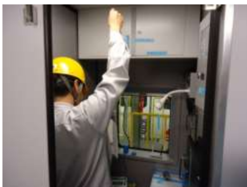
圖 2-51：空調出風量量測
