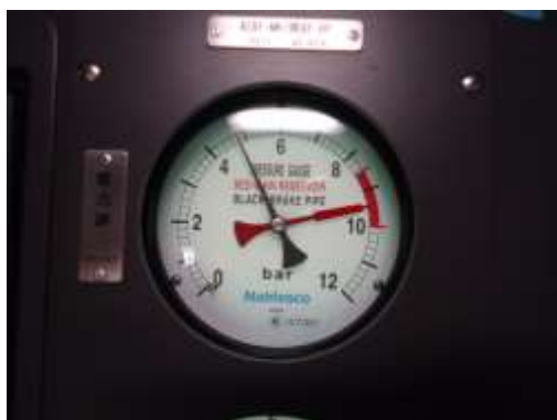
圖 2-25：BP 壓力洩漏檢測
