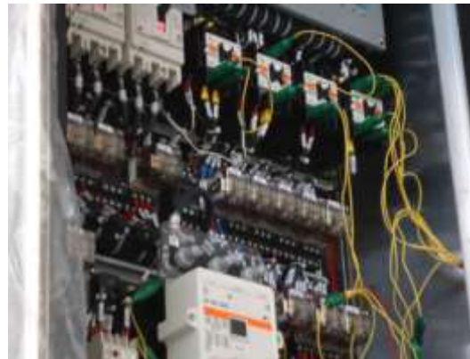
圖 2-6：測試用鱷魚夾夾定位
