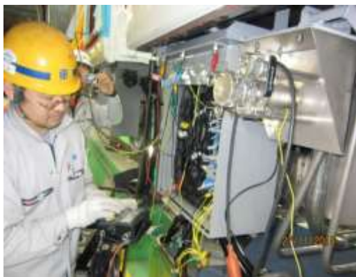
圖 2-9：低壓配電箱回路測試
