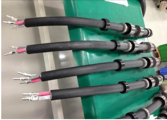
圖3-85 高壓電氣跳線製作半成品
