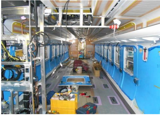
圖3-43 TEPCO1016車廂走道內部配線
