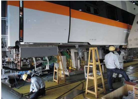
圖3-33 車下設備管線安裝作業
