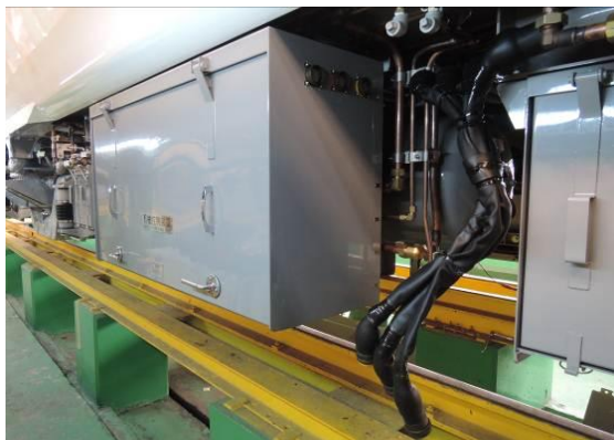
圖3-62 設備線路接頭拆下
