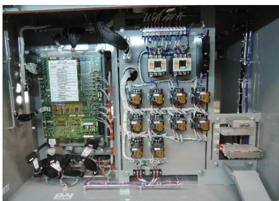
圖3-64 低壓電路控制箱
