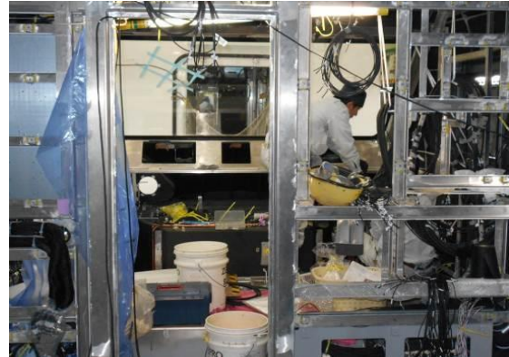
圖3-28 駕駛室管路配線安裝作業
