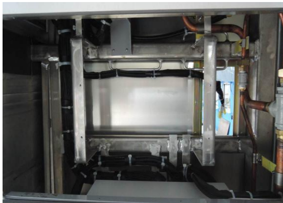
圖3-29 走道配電盤配線作業檢視
