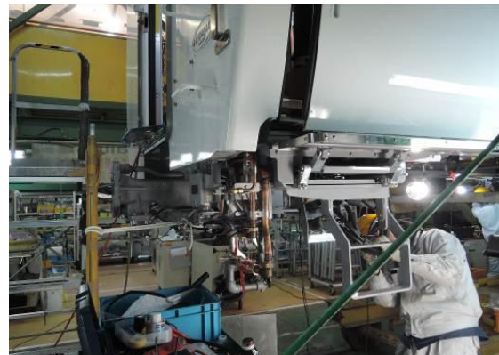
圖3-34車下設備管線安裝作業
