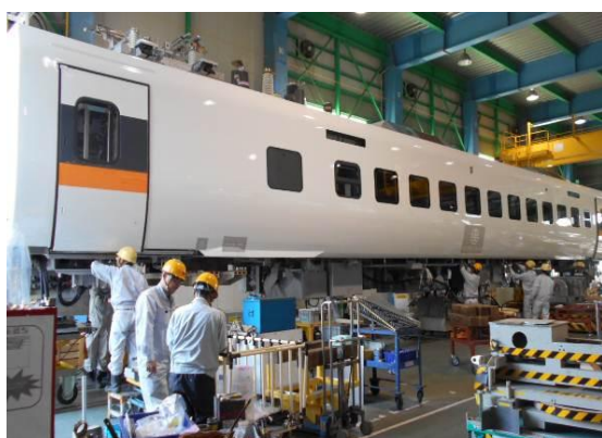
圖3-23 車下設備元件及管線安裝
