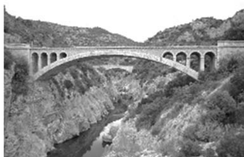
埃霍河上的新橋及水道橋
