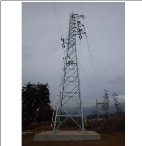
圖38、完工之既設鐵塔加固
