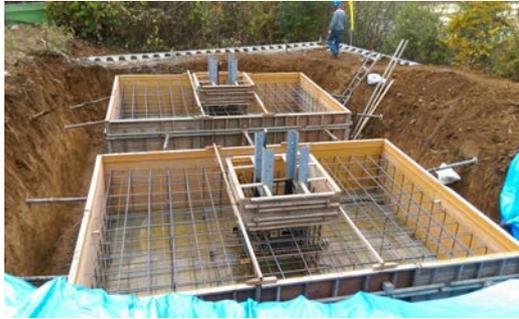
圖32、邊坡上門型鐵構基礎施工
