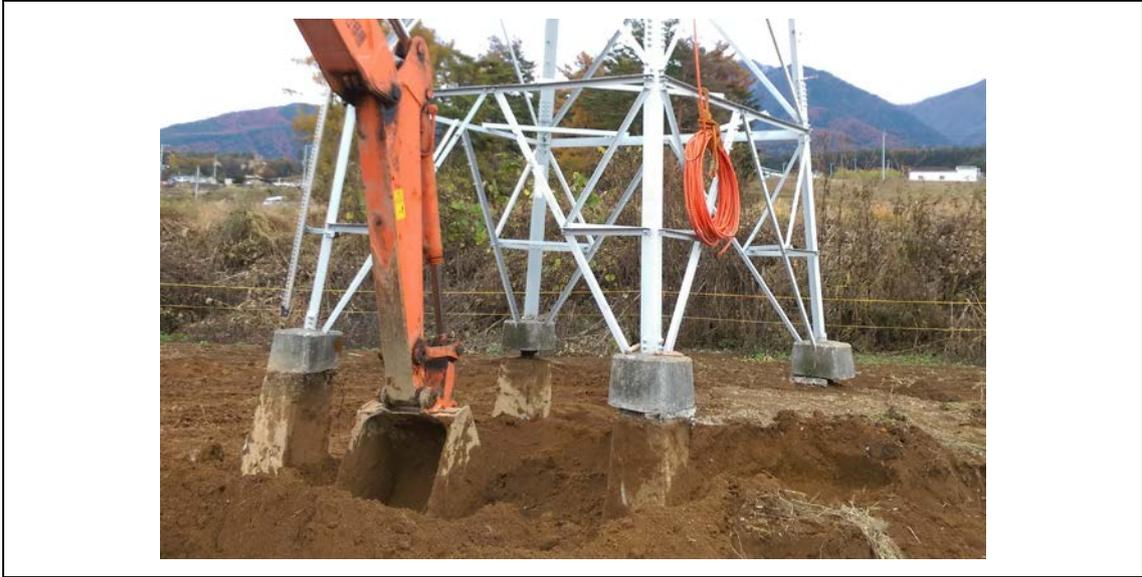
圖35、開挖中之鐵塔淺基礎
