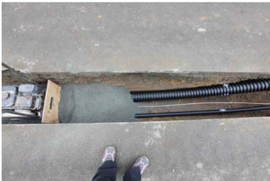
圖30、直埋22kV管路
