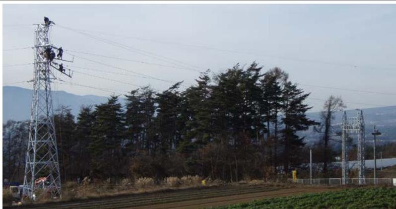
圖34、門型鐵構與既設鐵塔（日後改造為塔上型連接站）架線工作
