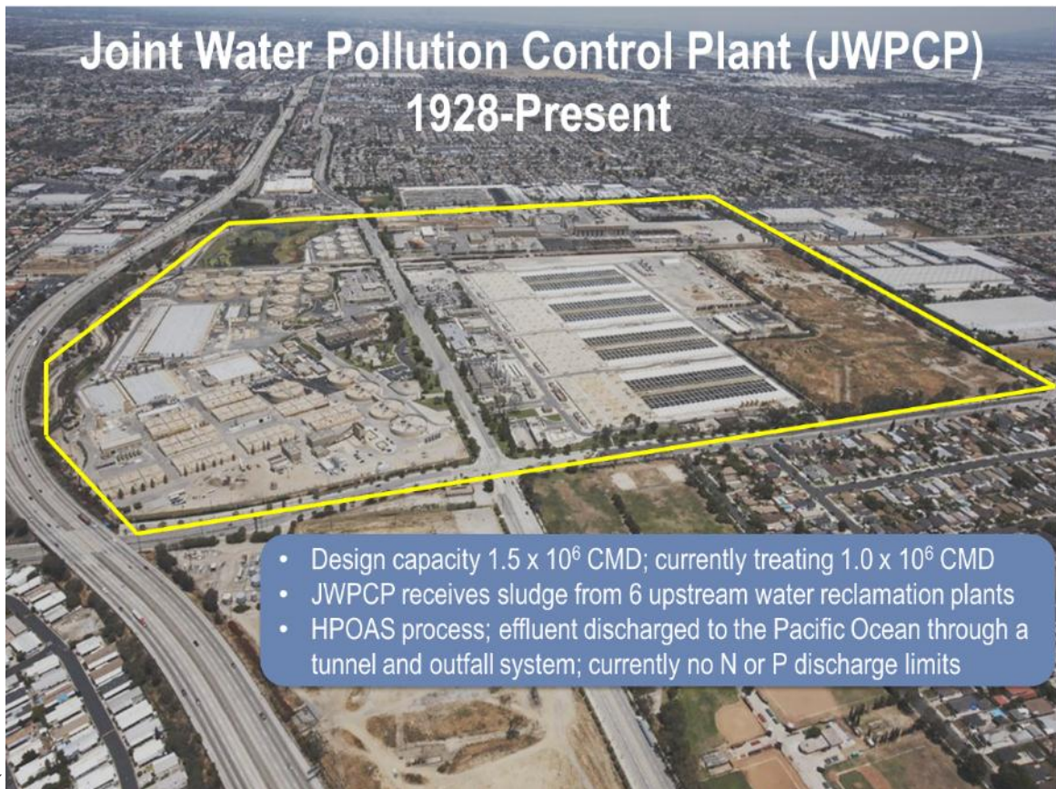
圖 13 聯合水污染控制廠(JWPCP)俯視圖 (湯繼城博士提供)
