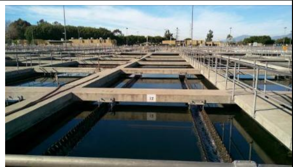
San Jose Creek 污水處理廠沉澱池
