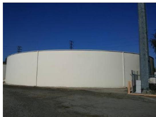
Lakewood 市淨水場清水池
