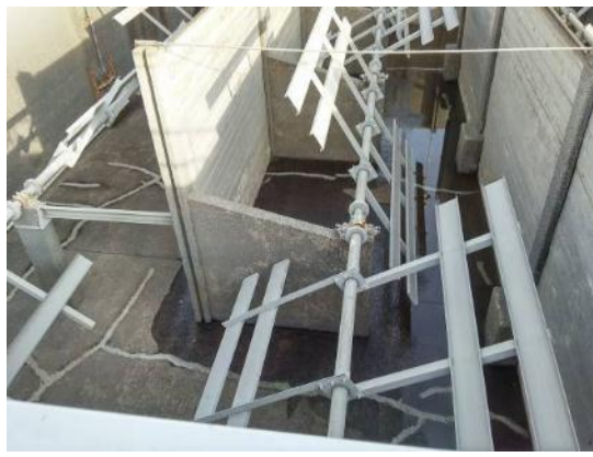
Fairbairn 淨水場閒置混凝(快混)池
