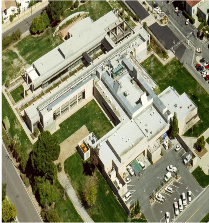
圖 32 南加州大都會水務署(MWDSC)水質中心俯視圖(梁善博士提供)
