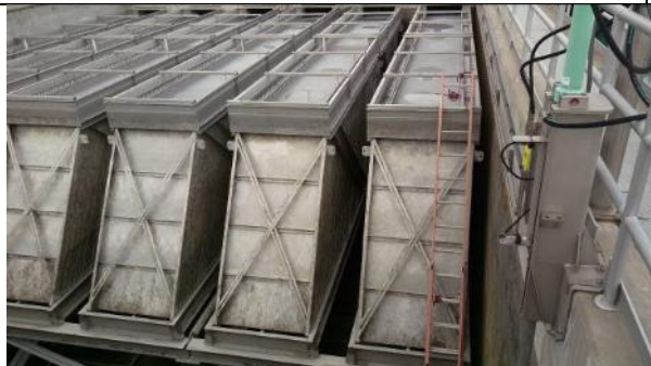
Benicia 淨水場閒置沉澱池(傾斜板)
