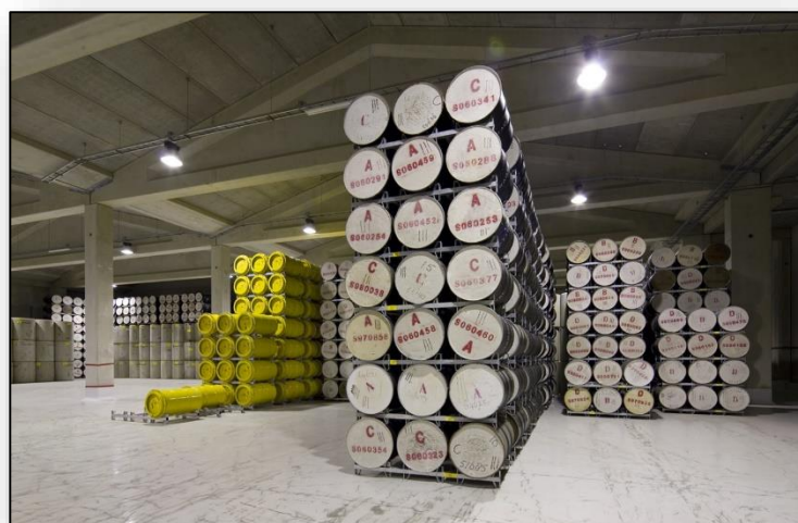
圖 8、COVRA 中、低放射性廢棄物貯存庫內部貯存配置
