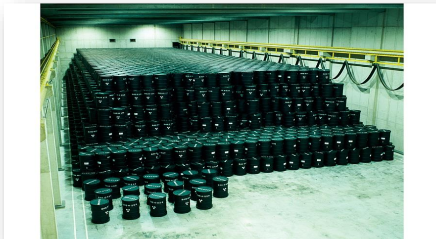
圖 21、低放射性廢棄物中期貯存設施-151 廠房
