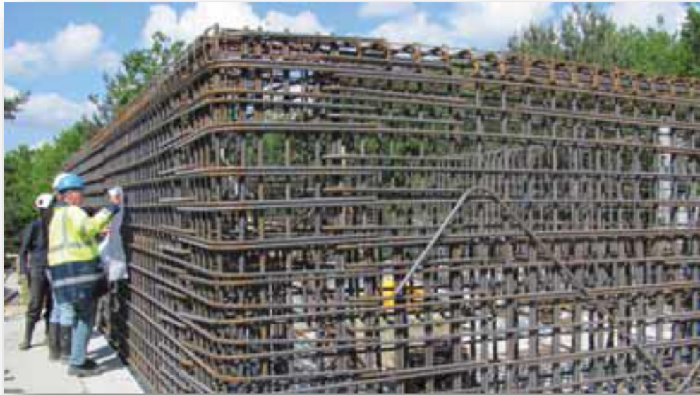
圖 28、處置窖施工照片
