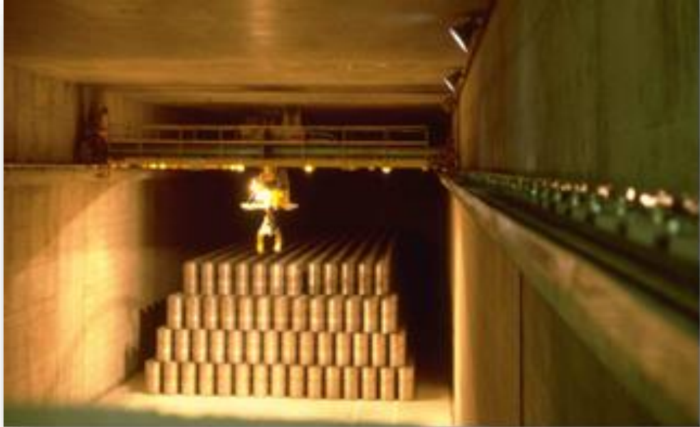
圖 22、中放射性廢棄物中期貯存設施-127 廠房
