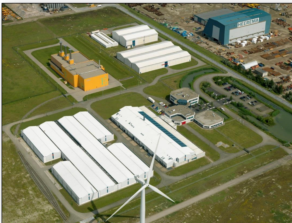
圖 3、COVRA 場區設施
