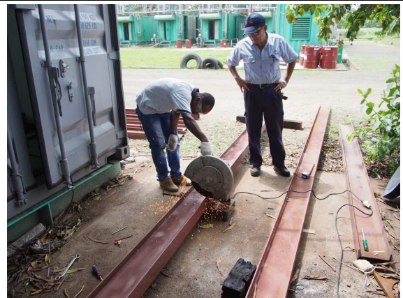
圖 15. 發電機定子吊架支撐架製作
