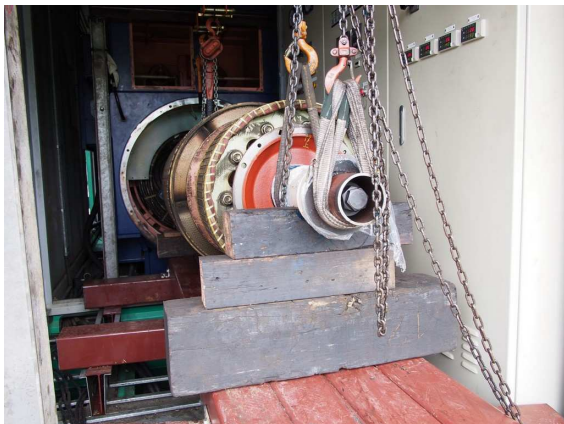
圖 11. 發電機轉子安置定位
