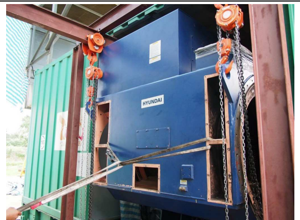
圖 21. 發電機定子線圈吊出
