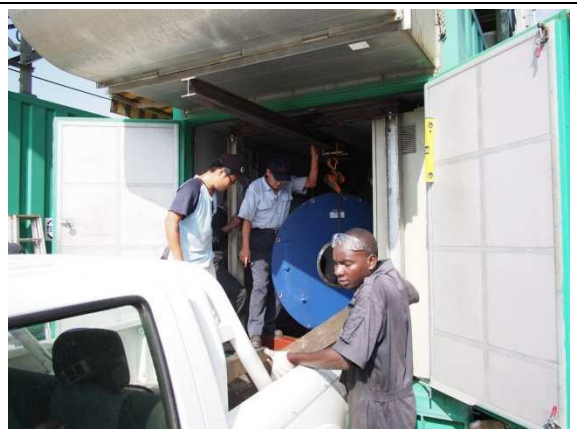
圖 4. 發電機後蓋吊出
