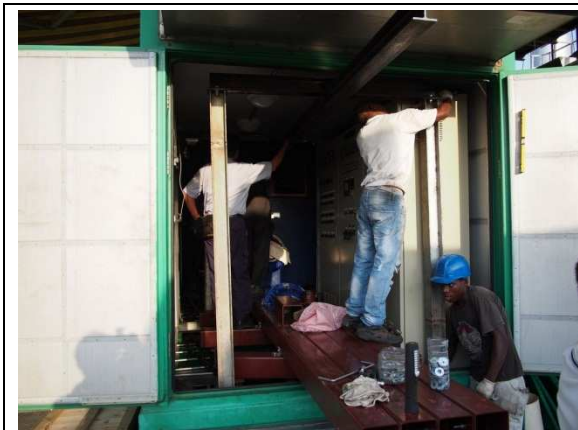
圖 1. 發電機後蓋吊架組裝
