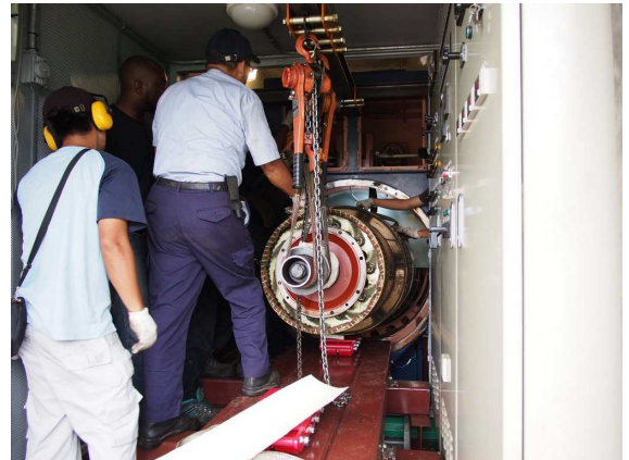
圖 10. 發電機轉子抽出
