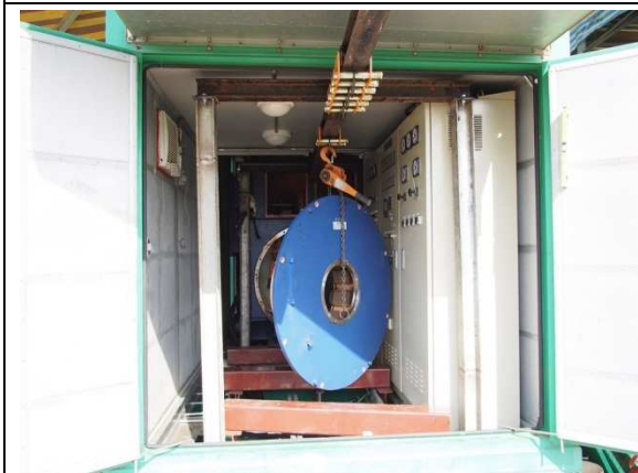
圖 3. 發電機後蓋勵磁機吊出
