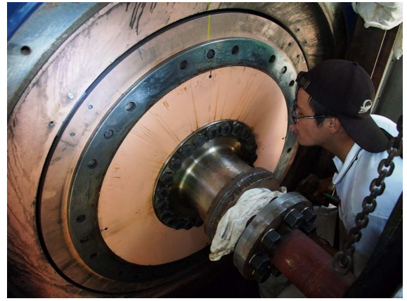
圖 6. 前蓋風扇與發電機軸聯結螺栓拆解
