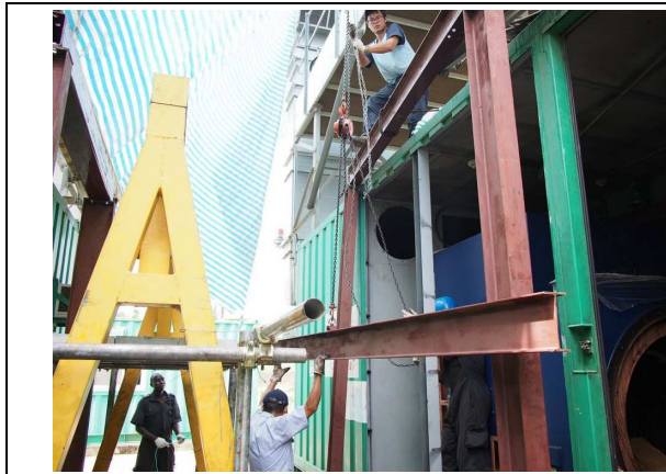
圖 18. 發電機吊架軌道橫樑安裝
