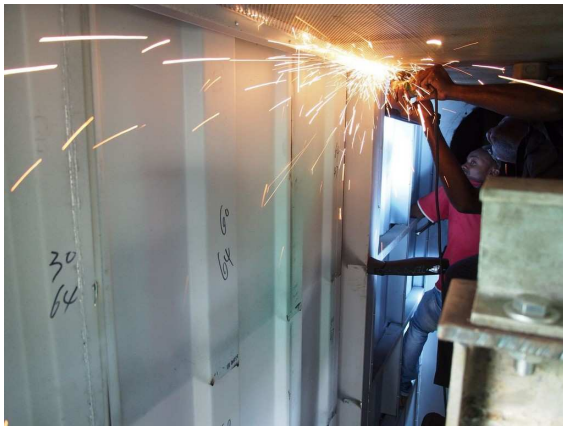
圖 12. 貨櫃支撐梁柱切除
