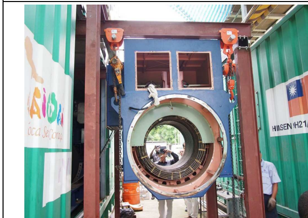
圖 22. 發電機定子線圈移出
