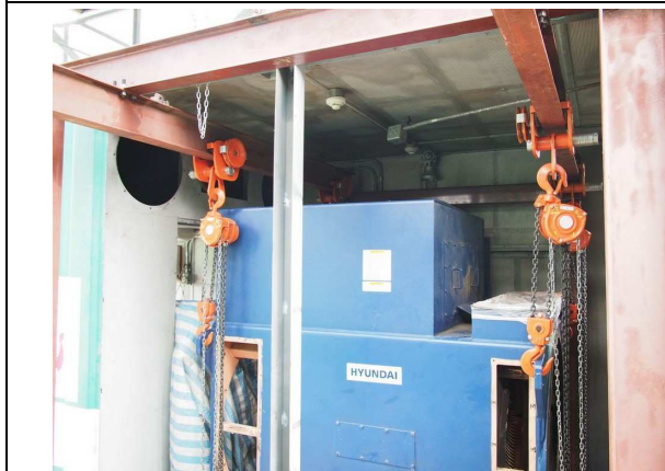
圖 20. 軌道滑車與鍊條吊車安裝
