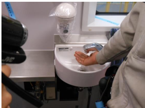
圖 1-48 洗手槽沖水檢視
