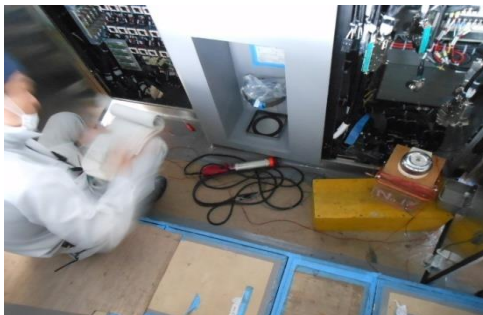
圖 1-25 配線導通作業(駕駛室)
