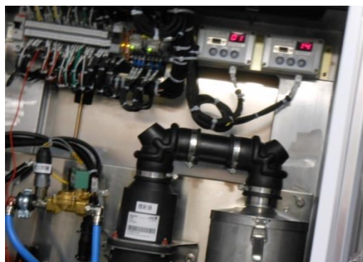
圖 1-53 男/女廁便器沖水控制測試
