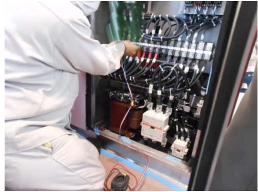
圖 1-81 SIV 電壓相序檢測
