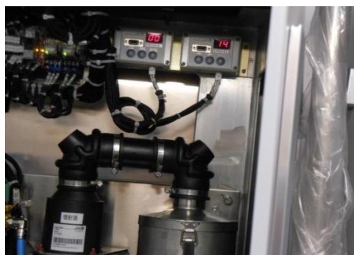
圖 1-51 男/女廁便器沖水控制測試
