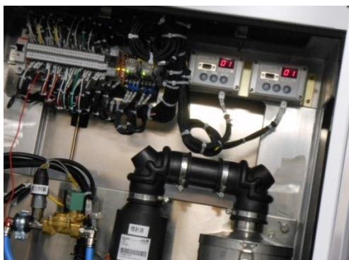
圖 1-52 男/女廁便器沖水控制測試
