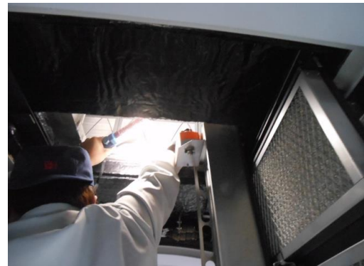
圖 1-89 車廂頂雨漏檢視
