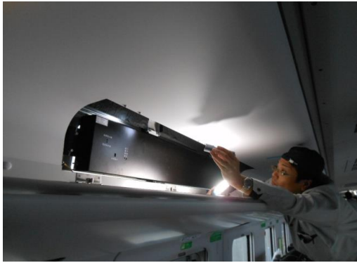
圖 1-90 DI 與行李架雨漏檢視
