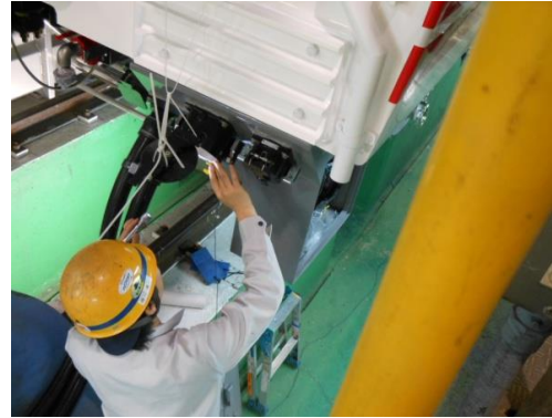
圖 1-24 配線導通作業(車下端)
