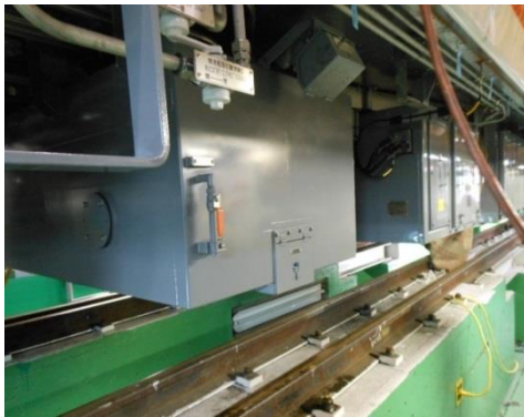
圖 1-46 驗水閥考克正常位與注水到全滿
