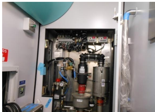
圖 1-49 男/女廁便器沖水控制測試
