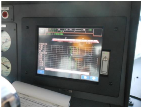
圖 1-74 主變壓器測試
