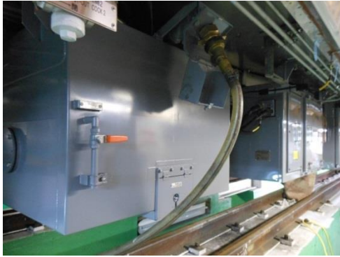
圖 1-44 驗水閥考克隔離與注水
