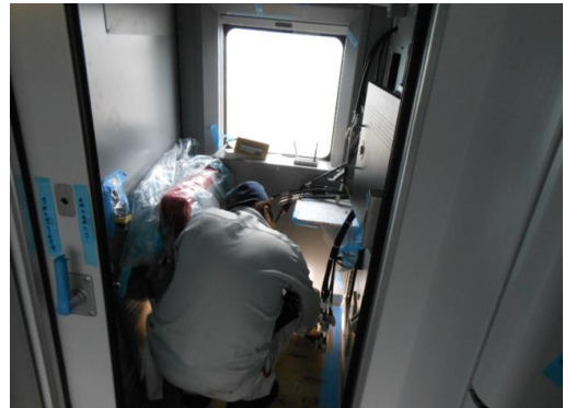
圖 1-93 車長室雨漏檢視
