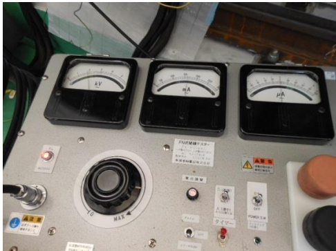
圖 1-31 TEP2035 高壓耐壓測試(1.9KV)
