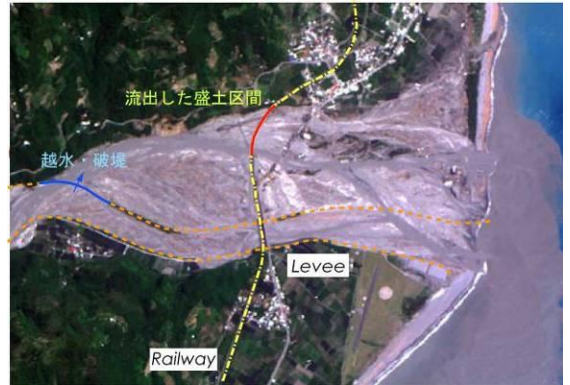
写真13 洪水後の氾濫状況：図中のオレンジ色の破線は旧河道の堤防ラインを、黄色の一点鎖線が鉄道（河川区間では盛土区間）を表す。
