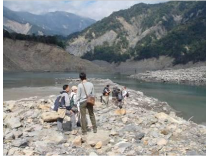
写真11 深層崩壊による天然ダム
