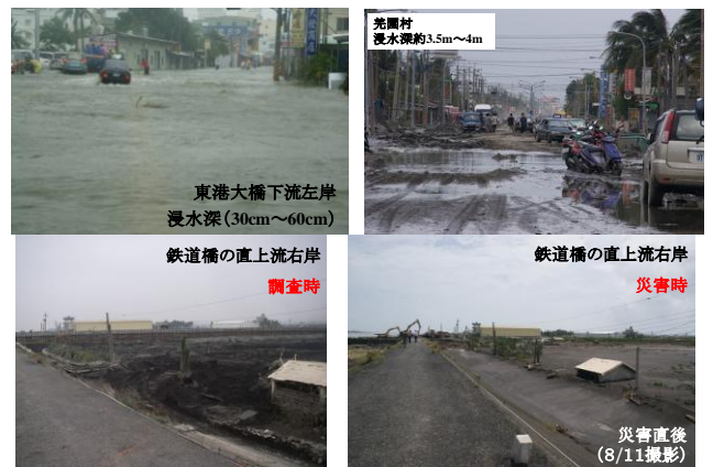
写真 14 屏東県の浸水および土砂氾濫の状況 上の写真は成功大学防災研究センター提供
