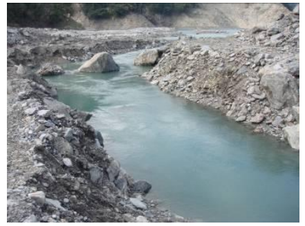
写真12 天然ダムに設置された排水路
