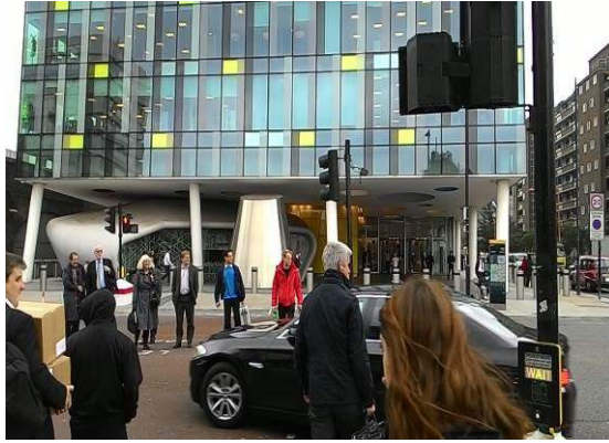
主控制中心大樓
