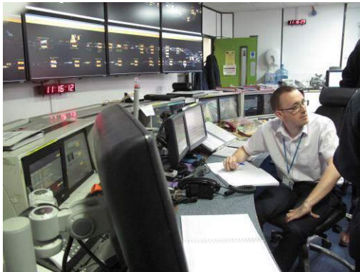
行車調度與監視控制台 1
