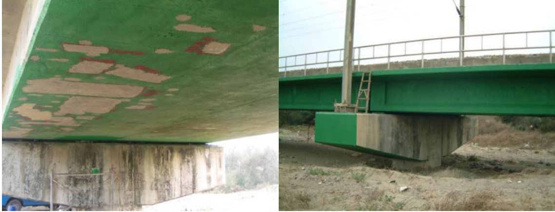
圖 伍-15 92 年施工步驟之易腐蝕面塗佈耐候漆
