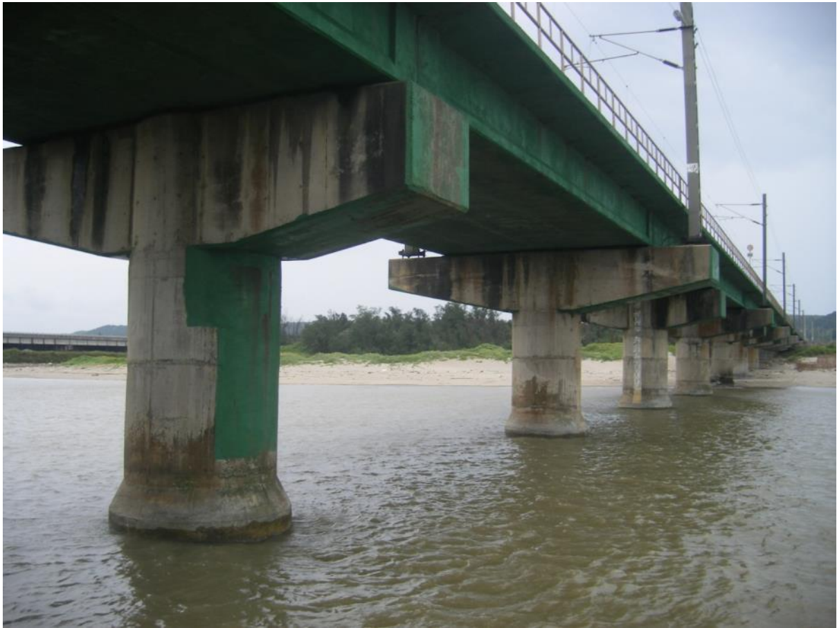
圖 伍-3 臺鐵海線下三叉河混凝土橋梁劣化數據分析例
