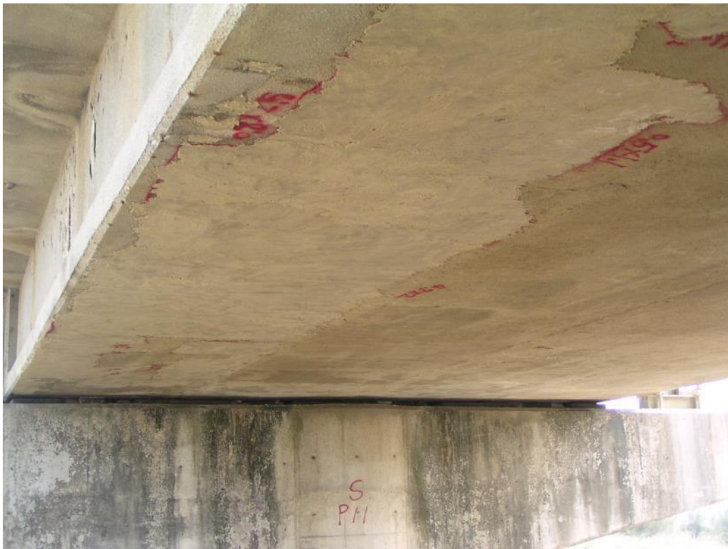
圖 伍-14 92 年施工步驟之混凝土補修材披覆完成
