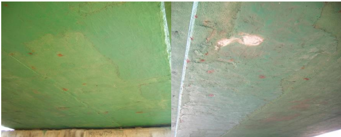
圖 伍-16 96 年間橋梁底版再度出現鋼筋鏽蝕跡象，於綠色耐候漆處出現鏽色斑點
