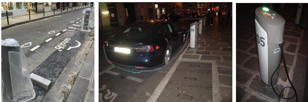
圖 4.8 市區電動小客車充電設施
