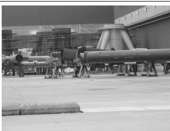
組裝完成之塔架及基樁
