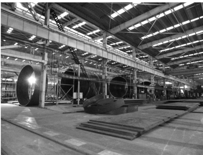
單樁圓周銲接作業及鋼板堆置
