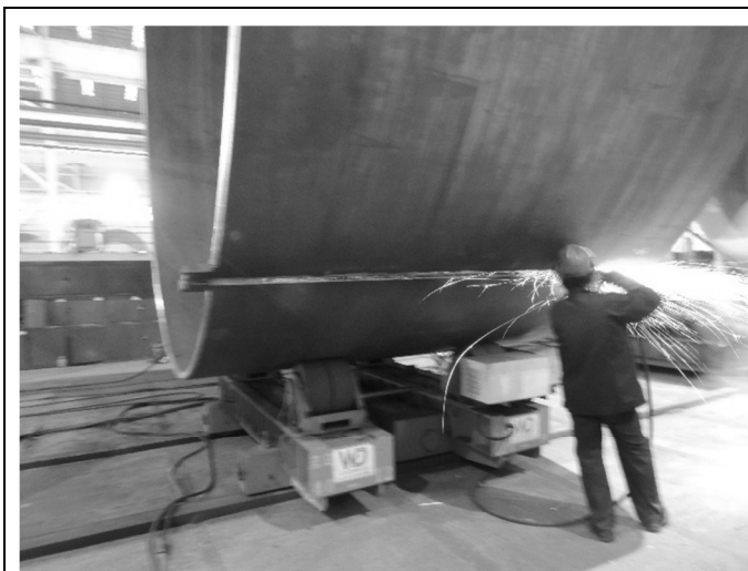
鋼管捲圓後之焊接
