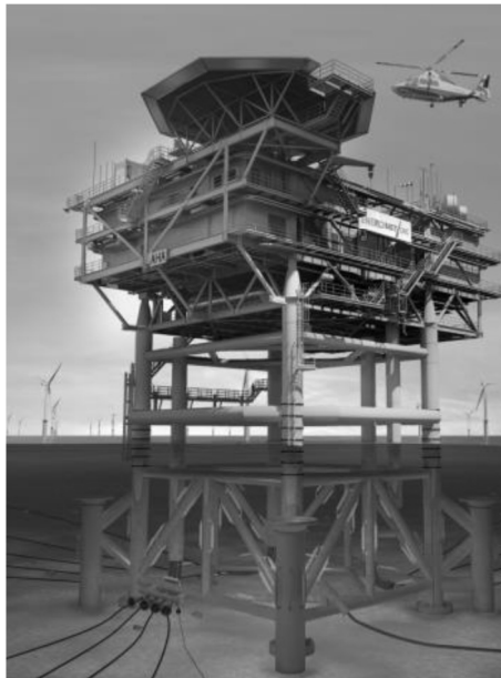
圖 4.5.4-7 風電場海上升變站(4)
