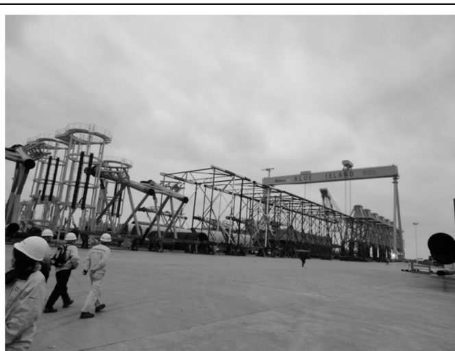
製作完成準備運送之離岸鋼構造(一)
