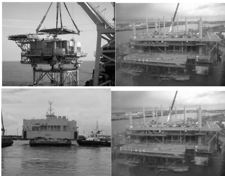
圖 4.5.4-10 風電場第二代海上變電站-增加了 1,500 噸，多出口電纜、多變壓器
