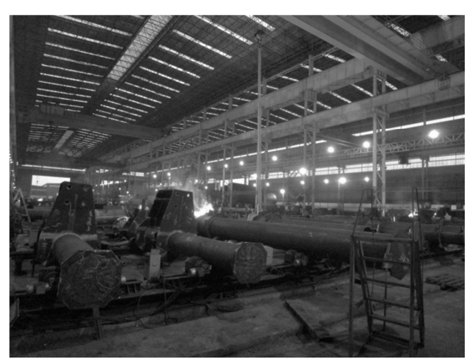
構件銲接作業
