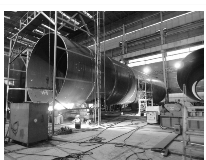
鋼管組裝銲接
