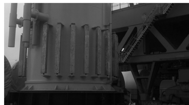
轉接段犧牲鋁合金陽極塊配置
