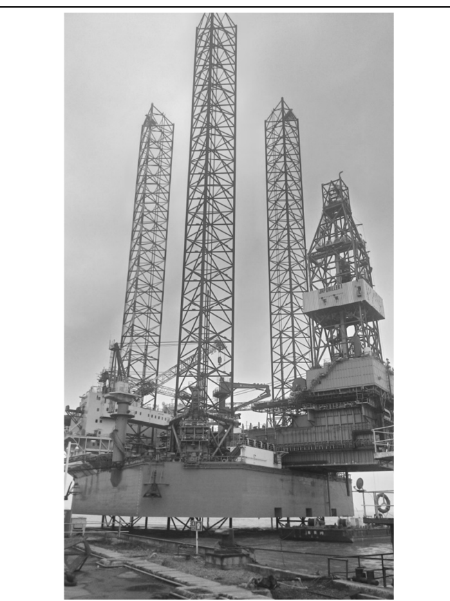
離岸頂升式平台
