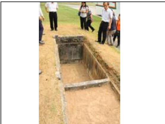
照片 21：水泥模板放入構成墓穴圍牆
