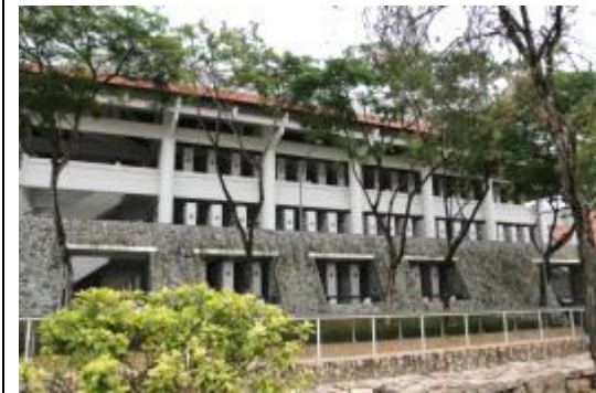
照片 13：開放式納骨設施
