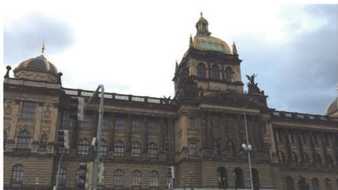
保留傳統建築的布拉格車站
