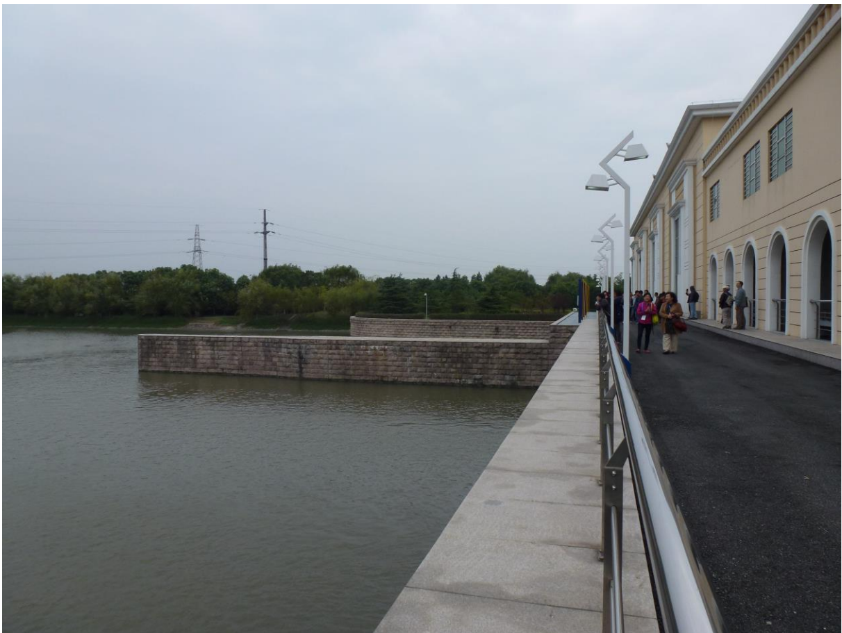
圖 18、西塘河閘泵工程外觀
