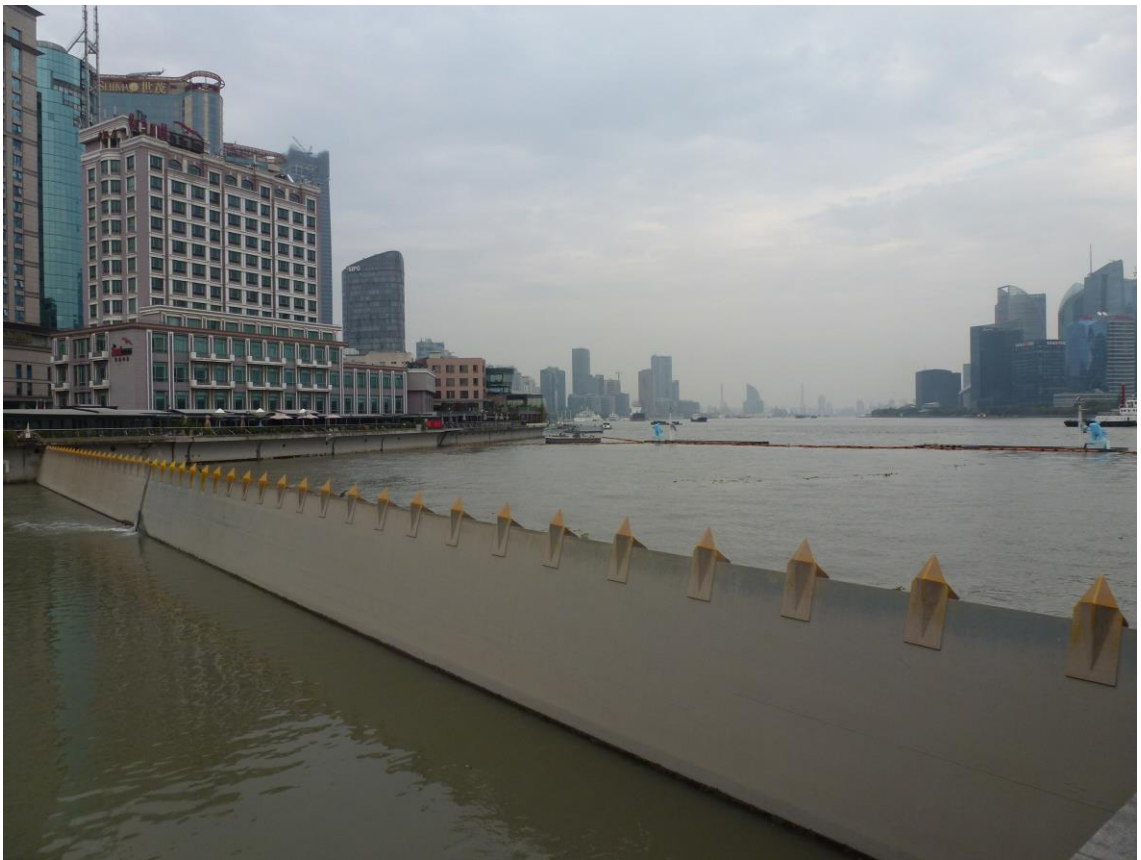
圖 7、黃浦江防洪工程（蘇州河擋潮閘）
