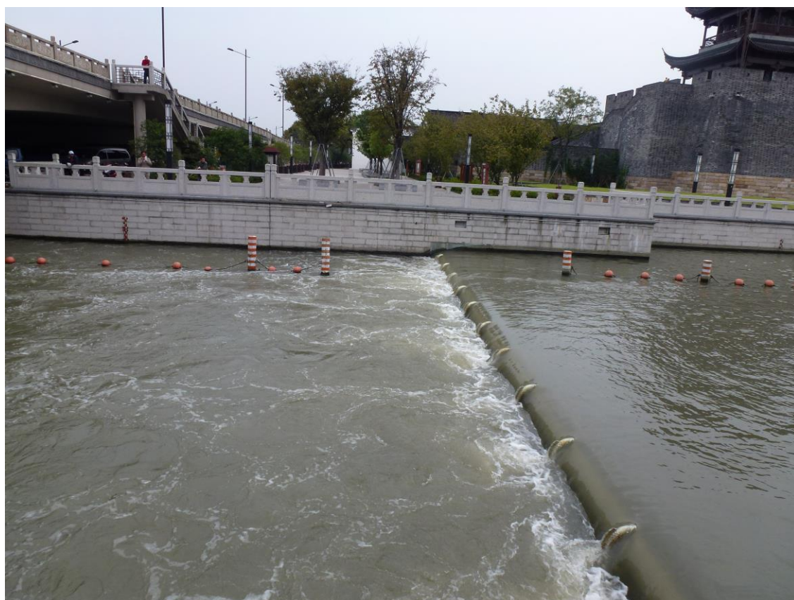
圖 21、蘇州古城區自流活水工程閘門溢流堰
