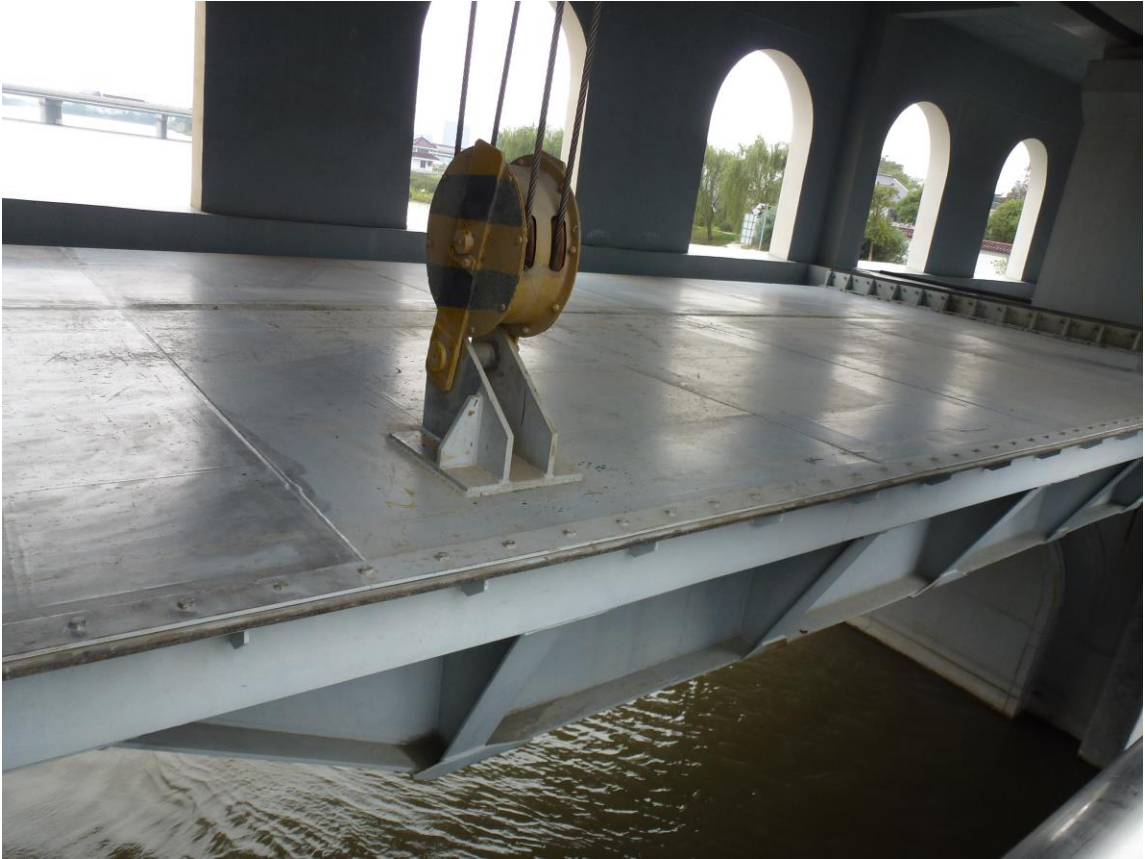
圖 19、西塘河閘泵工程閘門
