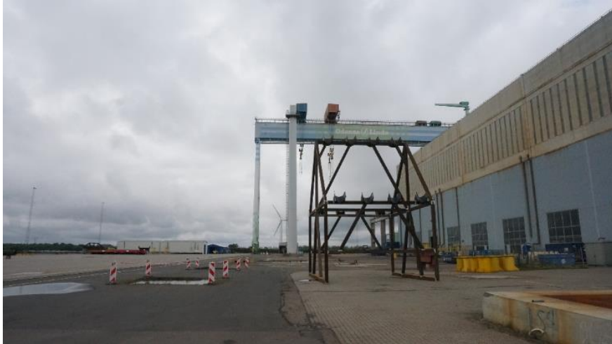
圖 6 1000 噸門型吊車及 Vestas 2 MW 機組之塔架
