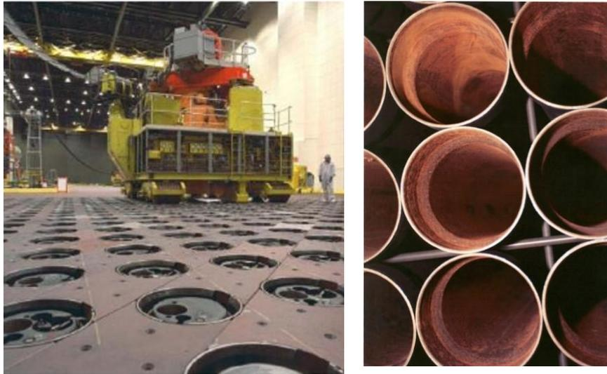
圖 14、英國 Wylfa 電廠用過核燃料貯存容
