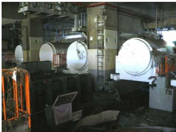
圖 15、日本福島第一核能電廠室內乾式貯存設施
