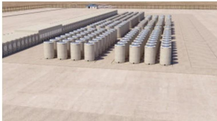
圖 21、WCS 集中式乾式貯存設施示意圖
